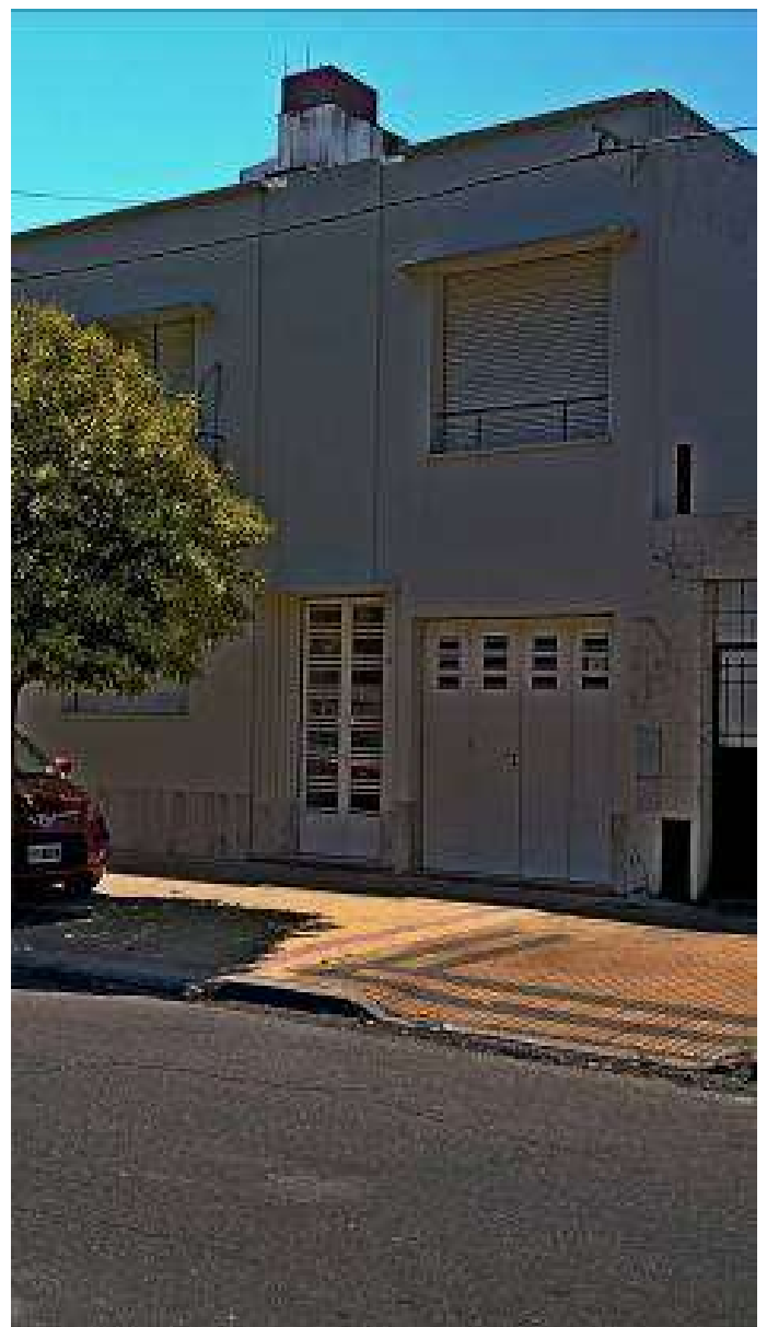
Fig. 4: Vivienda/Estudio Ingeniero Boudet, calle 64 entre 2 y 3, La Plata
